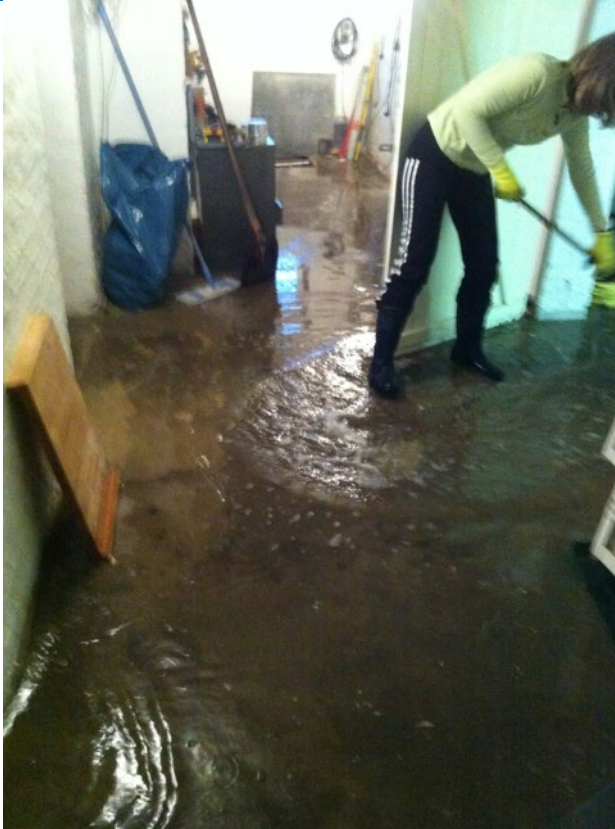
Rückstau ins Gebäude
