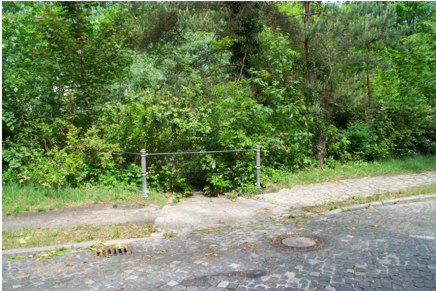
Abb. 13: Zulauf von Niederschlagswasser in den bestehenden Teich am Edelhofdamm
